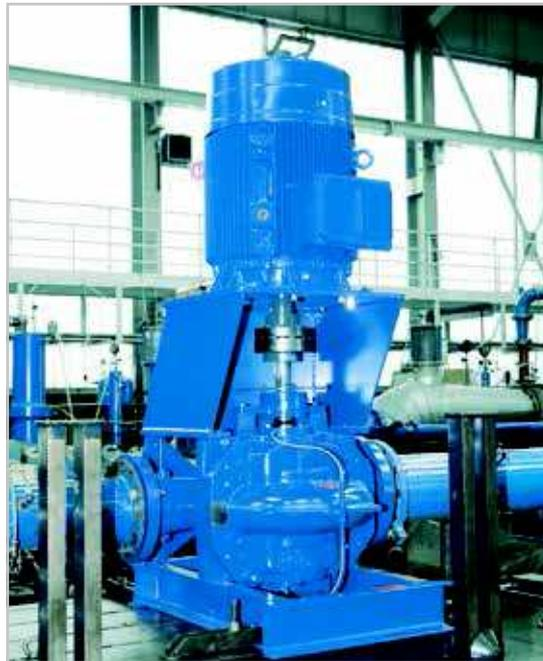
Omega, pompa KSB con corpo a spirale a rotazione inversa.
